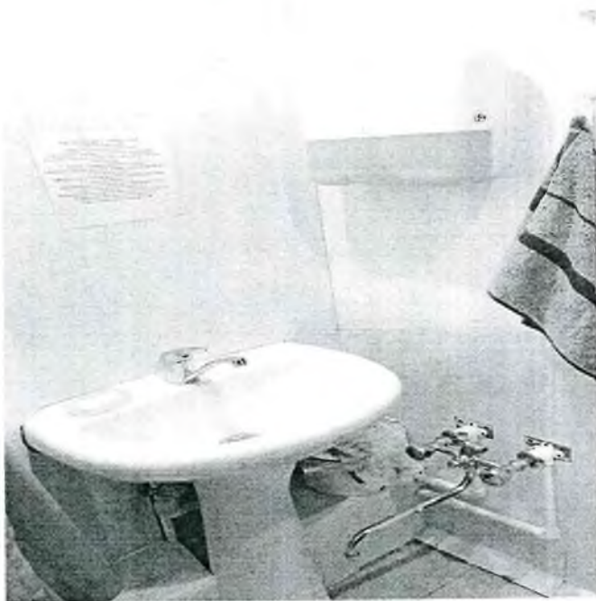
Фото № 5-6: Санитарно-гигиеническое помещение
